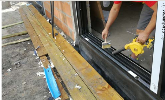
Fot. 8. Przed wstawieniem szyby należy dokładnie oczyścić otwór okienny
