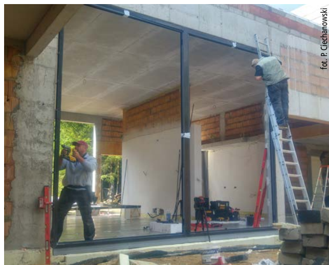
Fot. 5. Montaż konstrukcji okna wielkogabarytowego
