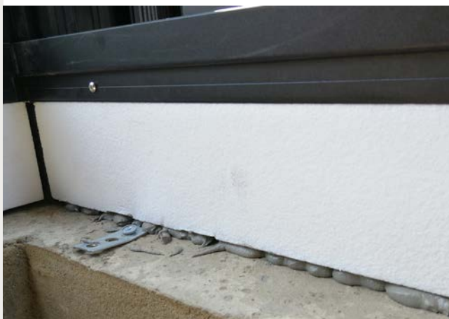
Fot. 7. Okna wielkogabarytowe muszą być odpowiednio podparte, zamocowane i zaizolowane
