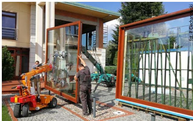
Fot. 10. Transport szyby z użyciem przysawek i i manipulatora
