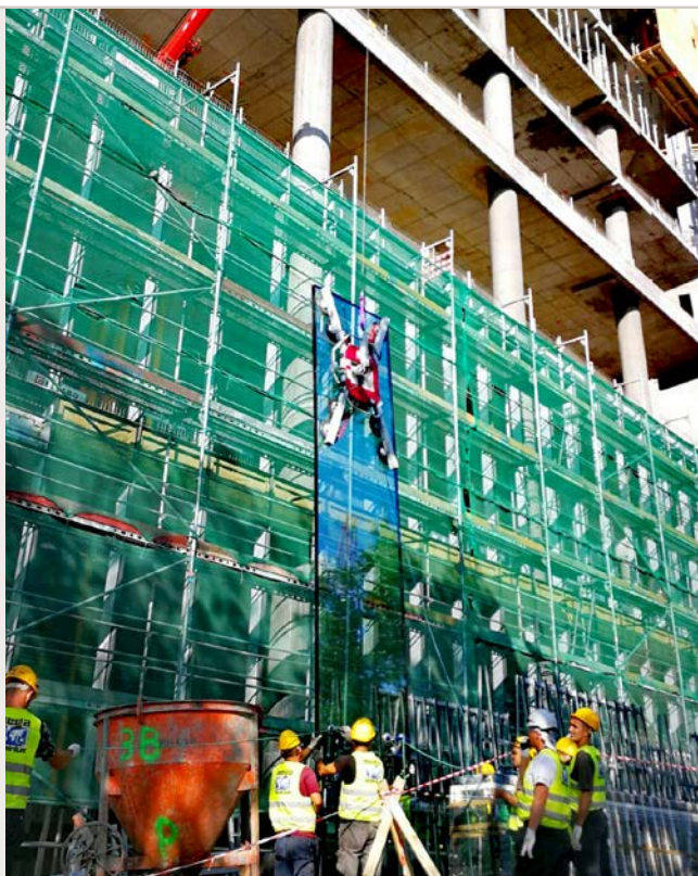
Fot. 17. Montaż wielkowymiarowego elementu konstrukcji fasadowej
