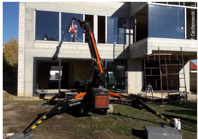
Fot. 16. Montaż szyby na wyższej kondygnacji
