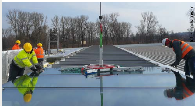
Fot. 4. Montaż świetlika dachowego
