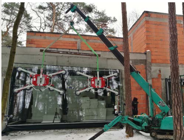
Fot. 11. Montaż ciężkiej szyby wymaga odpowiedniego sprzętu i ogromnej precyzji
