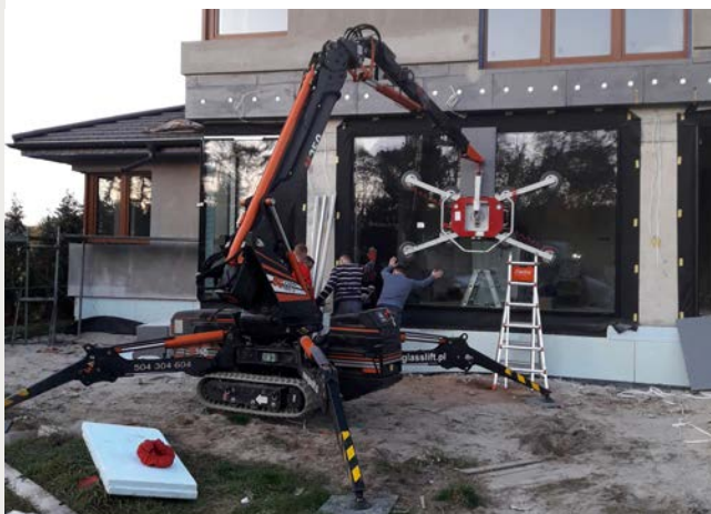
Fot. Montaż okna typu Fix
