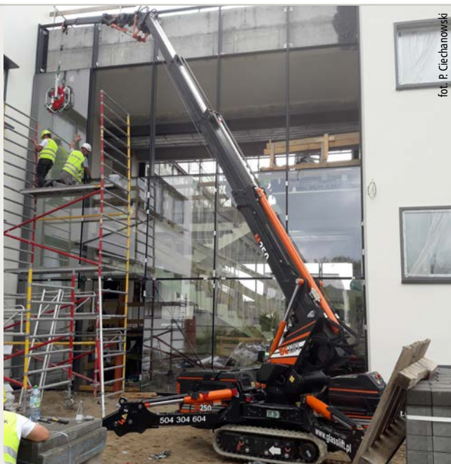
Fot. 3. Montaż konstrukcji fasadowej
