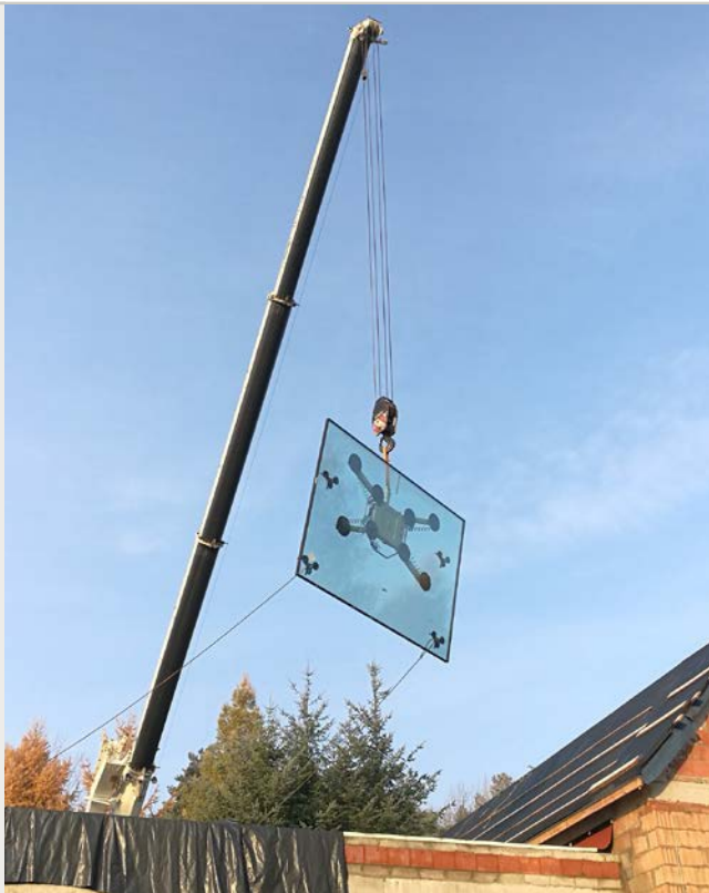
Fot. 13. Przenoszenie szyby przy pomocy żurawia
