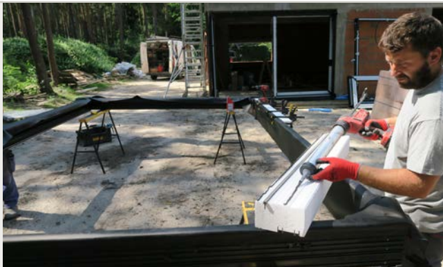
Fot. 6. Izolacja termiczna ramy okna
